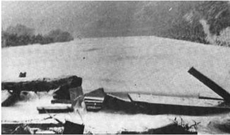
*Hochwasser 1910: Fortgerissenes Gerüstmaterial vom Eisenbahnbau führte zu zusätzlichen Staus, die fast alle Ahrbrücken wegrissen*
