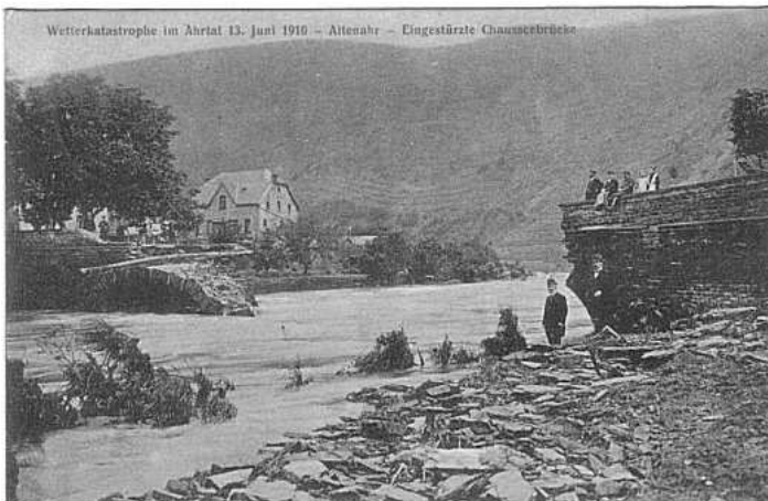
Zerstörte Straßenbrücke in Altenahr
