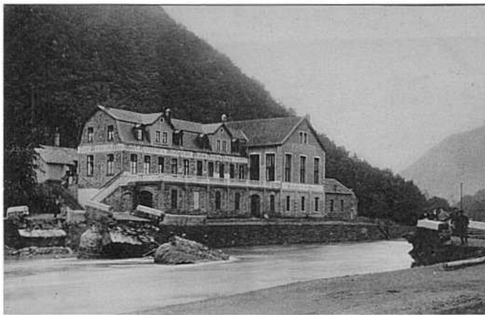
Zerstörte Brücke zum Weinbauverein in Dernau
