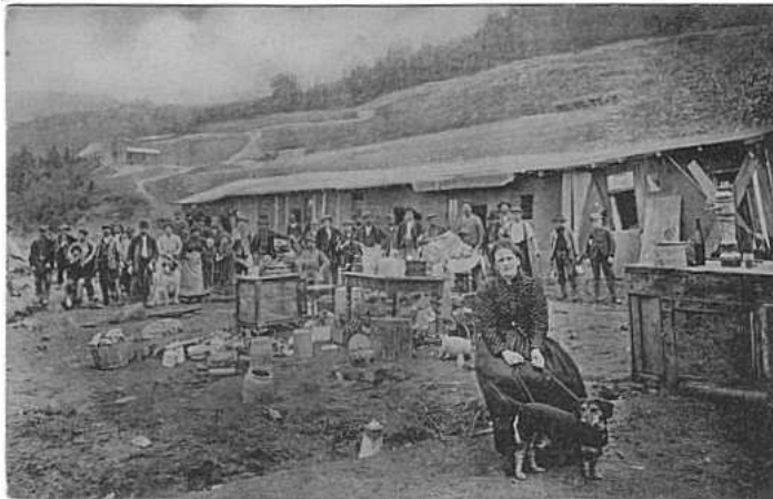
Wirtin (Frau Schober) mit ihrem Hund vor dem Rest ihrer zerstörten Kantine, dahinter Baubaracken der im Bau befindlichen Bahnstrecke bei Antweiler. Frau Schober wurde von ihrem Mann gerettet, welcher selbst dabei ertrank mit einem Kind, das ihm aus der Hand fiel. Hab und Gut und ca. 8000 Mark bares Geld gingen mit verloren. Auch drei andere Kinder sind ertrunken.
