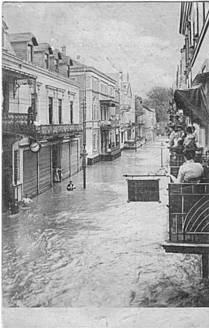
Überflutete Poststraße in Bad Neuenahr. Das Wasser stand ca. 1 Meter hoch.
